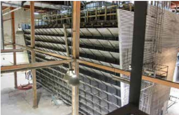
Ancienne tour d'eau datant de 1976.
