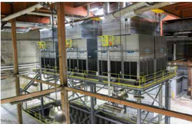
Nouvelle tour d'eau.
