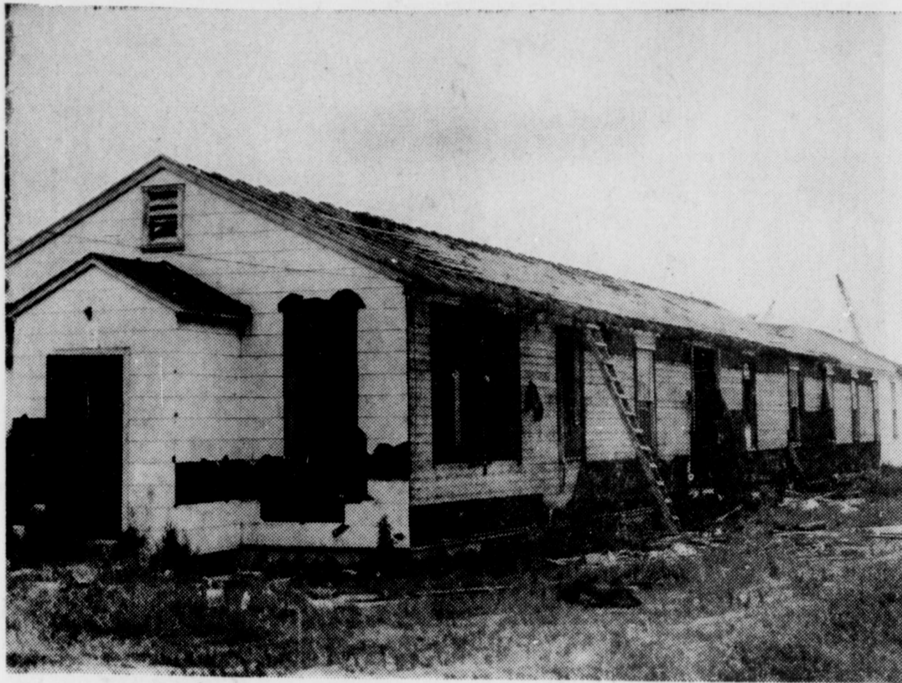
CINQ DES BARRAQUES construites en 1940 afin de procurer des chambres aux milliers de travailleurs qui étaient employés durant la guerre par Marine Industrie Limitée et Sorel Industrie Limitée, sont en train d'être démolies. Nous voyons ici la baraque no 5 que des
