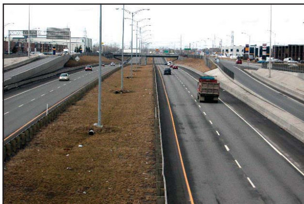
A-25 direction nord, entre l'échangeur d'Anjou et le boulevard Henri-Bourassa
