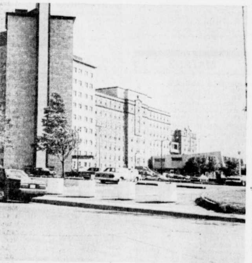
L'Hôtel-Dieu de Lévis est un hôpital général de plus de 500 lits.
