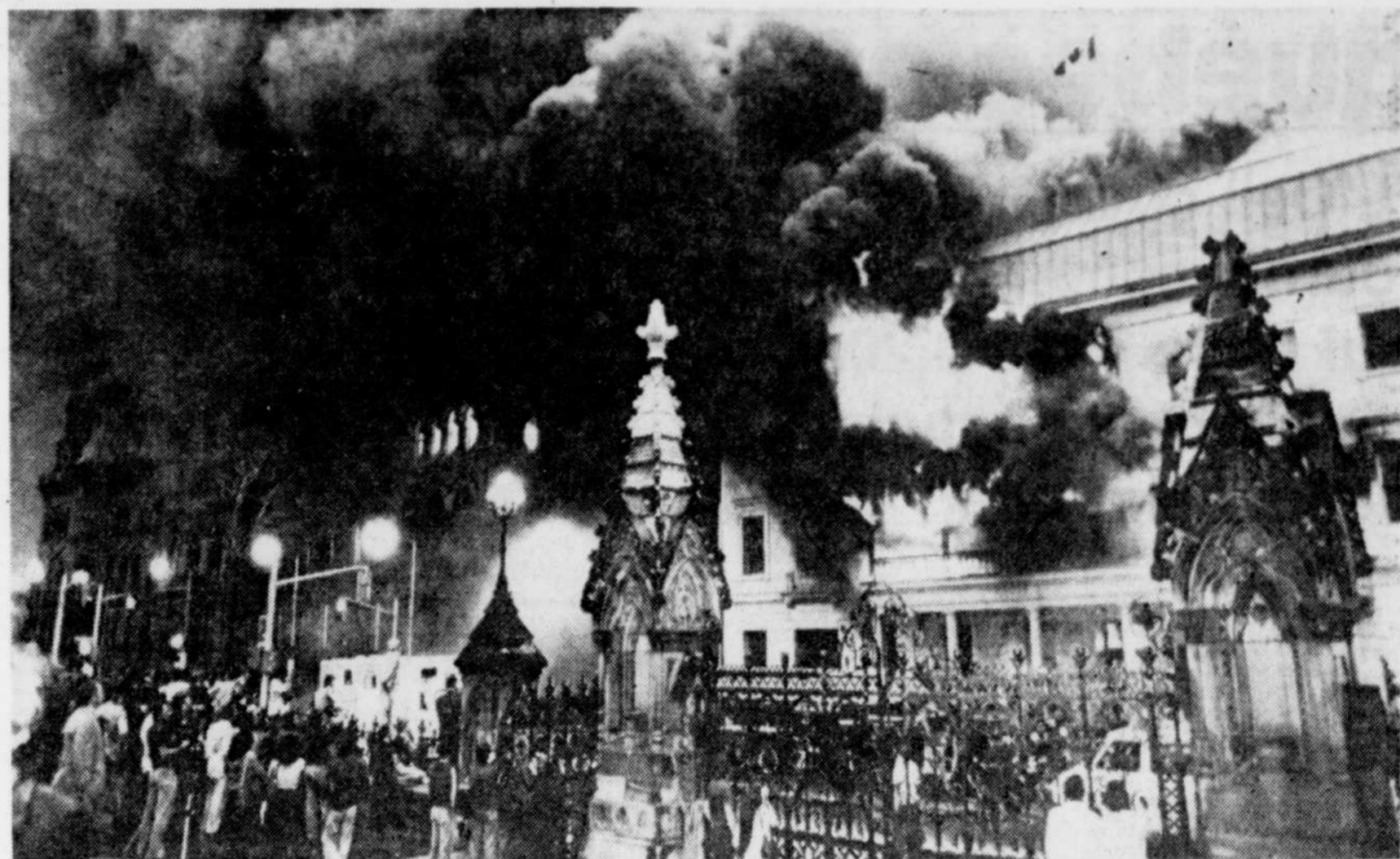
Ce qui avait commencé comme une simple odeur de fumée a rapidement pris de l'ampleur pour s'étendre aux quatre étages du club Rideau, situé en face du parlement.
