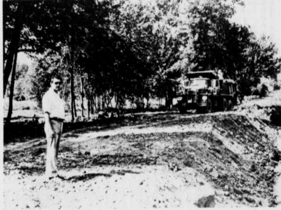
Au moins un millier de voyages de terre seront tirés de l'excavation nécessaire pour l'agrandissement à la centrale de filtration de Terrebonne et cette terre est apportée depuis la semaine dernière sur les berges de l'île St-Jean. Notre photo prise "entre les deux îles" où autrefois des centaines de terrebonniens venaient se baigner, montre cette partie de l'île où on décharge la terre dans l'anse. Le directeur des Travaux publics, M. Guy Saint-Pierre, supervise les travaux de remplissage.
