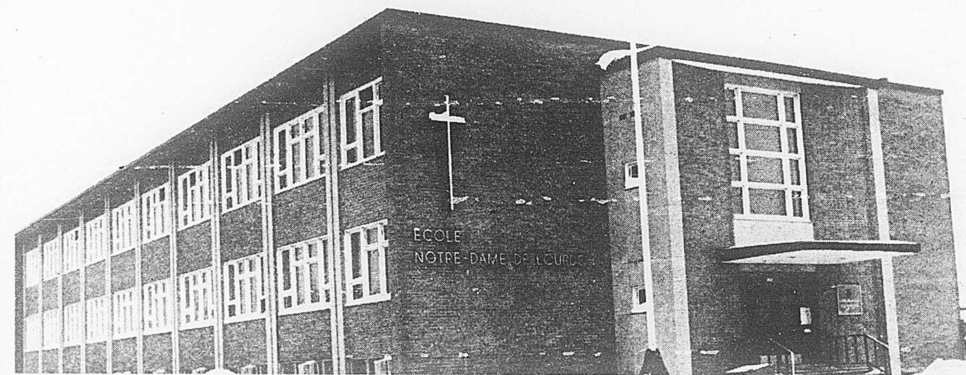
La bibliothèque municipale Germaine-Guèvremont, occupant le sous-sol de l'école désaffectée Notre-Dame-de-Lourdes, à Duvernay, sera vraisemblablement forcée de déménager d'ici quelques mois. Le ministre Bédard a annoncé son intention d'installer dans ses locaux, dès 1979, quelques-uns des services du nouveau district judiciaire.
