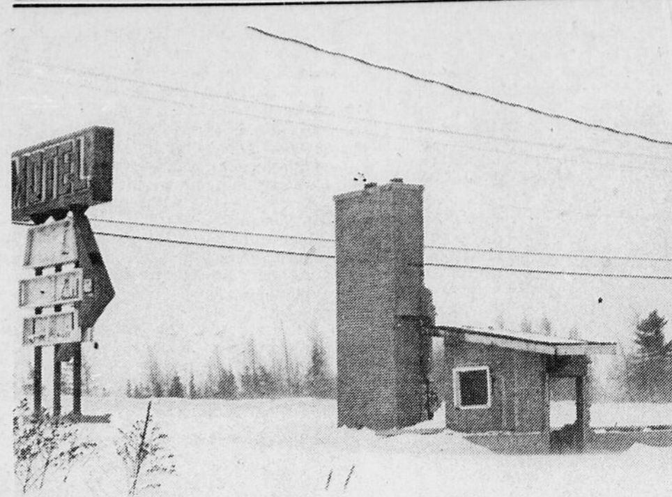
CATASTROPHE — Vision d'apocalypse, que cet incendie qui dévastait l'hôtel-motel Casse-croûte, le 10 décembre 1976.
