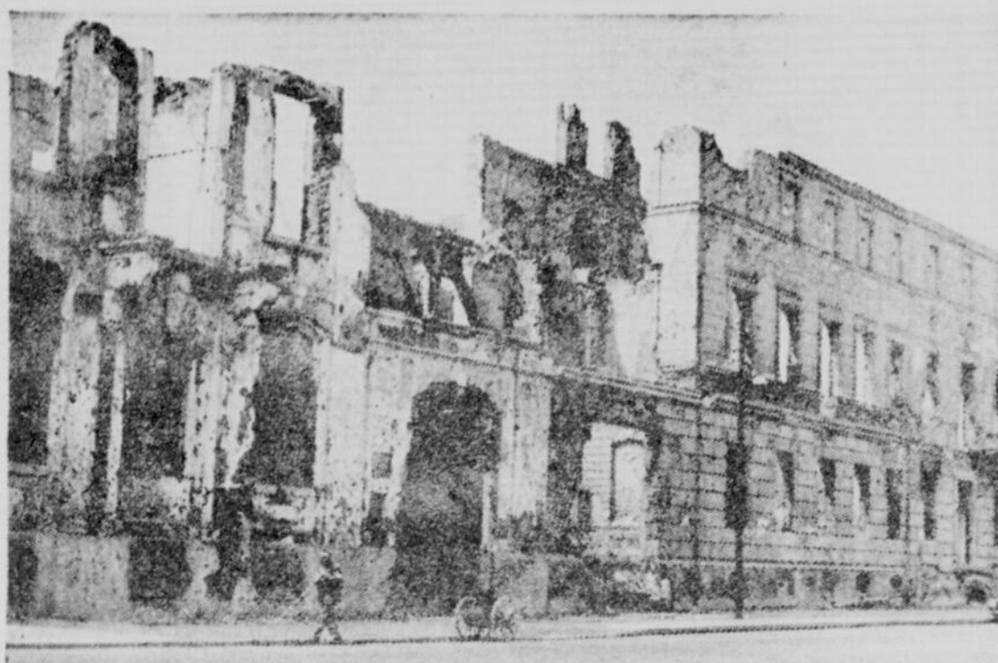
Des édifices en ruines, on en voit partout dans Berlin Est.
