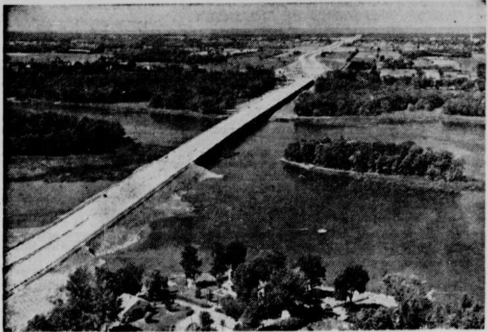
Le pont de la rivière des Mille-Iles
