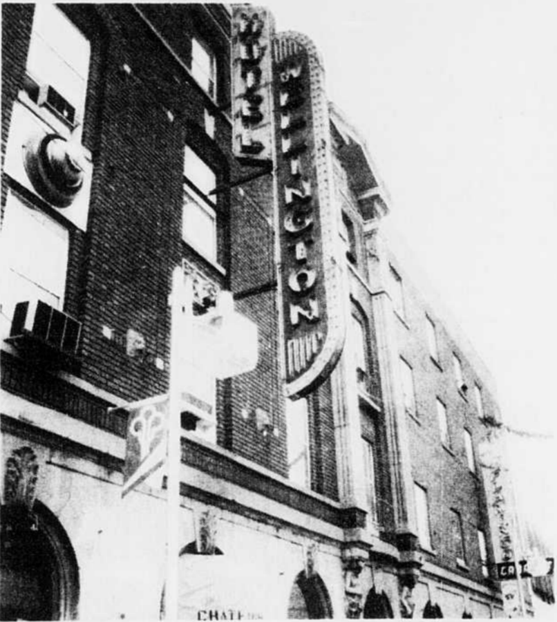
L'hôtel Wellington rouvrira graduellement ses portes à compter de février, le temps que l'on procède à son rafraîchissement et quelques rénovations.
