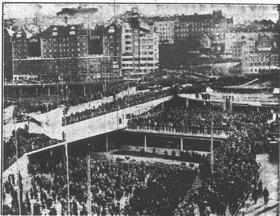
Cet enchevêtrement de passages à différents niveaux a fourni la solution au problème de la circulation dans le centre de Stockholm, en Suède. Le roi Gustave a présidé à l'inauguration de cette innovation en matière de circulation.
