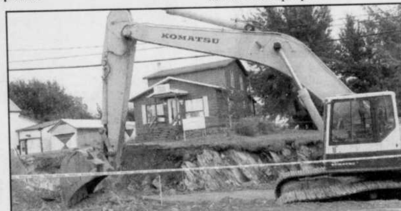
Cette boulangerie a dû fermer ses portes parce qu'un trou béant empêche les clients de s'y rendre.
