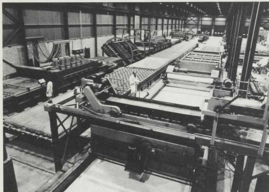
La chaîne de fabrication des produits en feuilles est constituée d'une suite ininterrompue de postes de façonnage, de séchage, de gabariage, de polissage, de feuillage et de finition.
