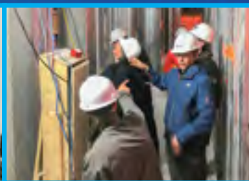
Visite en chantier
