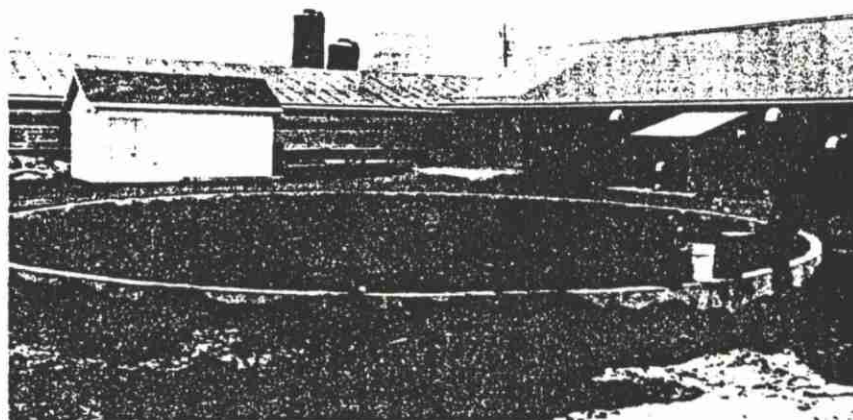
Le pilote Biosor est installé sur l'exploitation de Martin Deschenes dans l'île d'Orléans.
