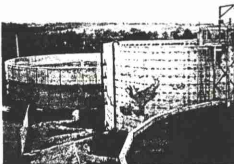
Station expérimentale de traitement des lisiers Caulnes (22)
