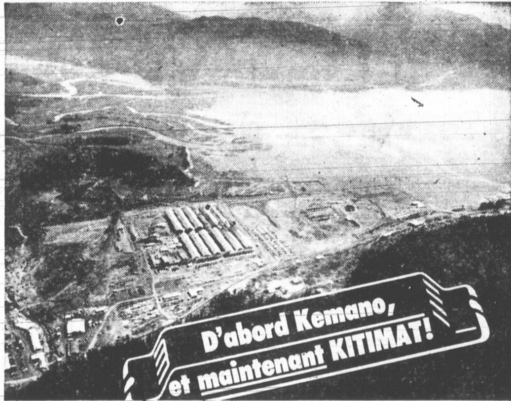
Vue aérienne des premiers travaux à l'aluminerie de Kitimat, C.-B.
