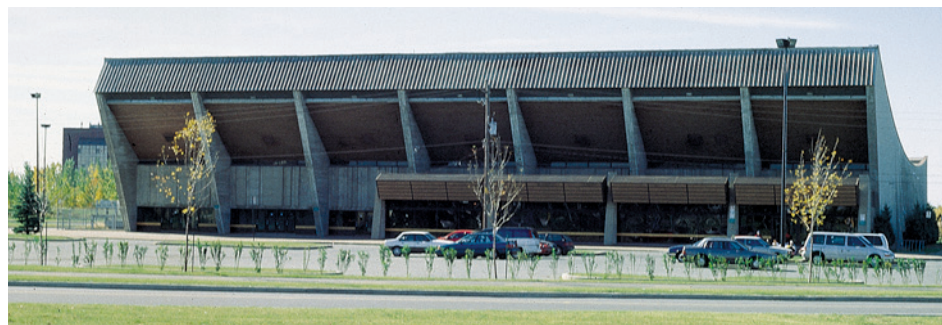
Des travaux débiteront bientôt au Colisée Jean-Béliveau.
