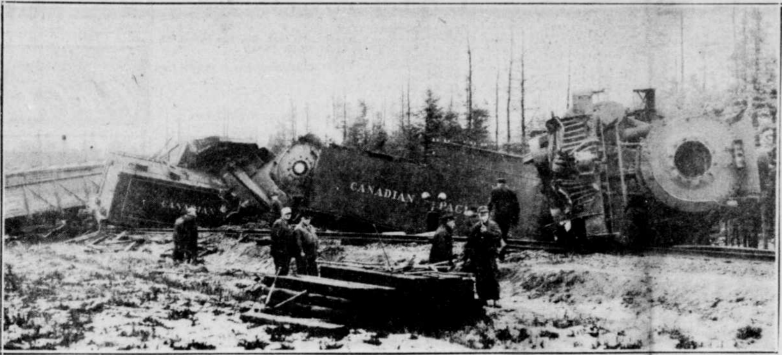
Deux locomotives hors de la voie — Cette photographie montre la position des deux locomotives d'un train de fret du Pacifique Canadien qui ont quitté la voie la nuit dernière à proximité de Birchton, après qu'une explosion se fut produite dans la première locomotive. Aux petites heures ce matin, une équipe de travailleurs, cheminots et sectionnaires du Pacifique Canadien, était déjà sur les lieux. On croit pouvoir déblayer la voie ferrée avant dix heures ce soir. (Photo La Tribune)
