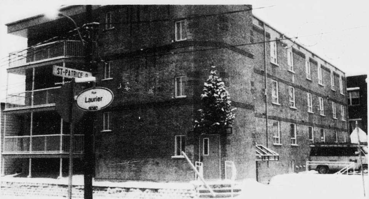
La Ville de Magog intentera une poursuite contre le propriétaire de la Résidence St-Patrice, sise à l'angle des rues St-Patrice et Laurier, pour avoir enfreint le règlement municipal relatif à la démolition des immeubles.
