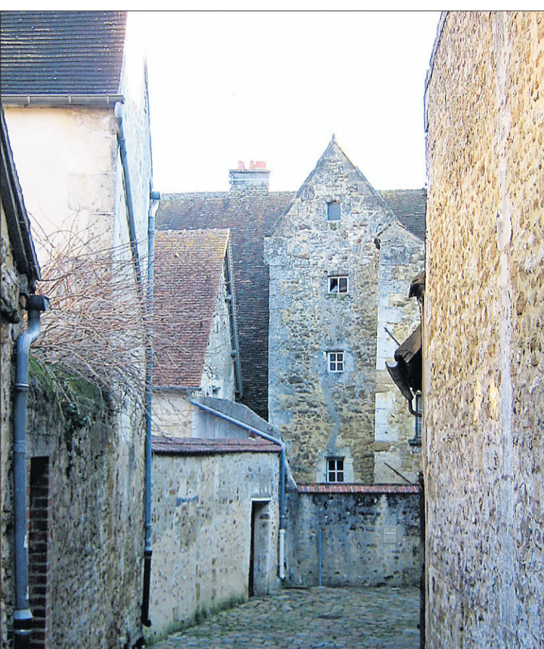
Ces maisons de pierre blonde sont les plus anciennes de Mortagne-au-Perche, petit bourg qui a donné un grand nombre de colons à la Nouvelle-France.
