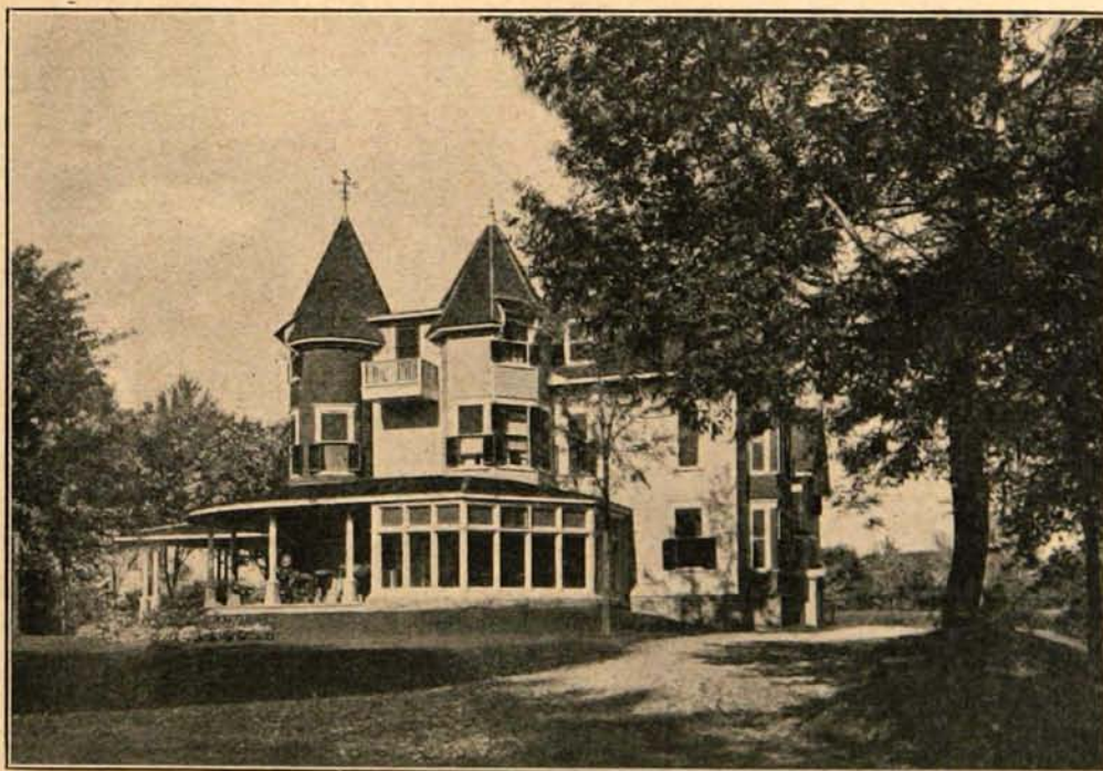
Vue extérieure du Sanatorium Prévost montrant en même temps le Solarium et un coin de la Veranda
