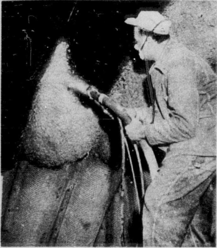
On a isolé les murs contre le froid en les revêtant de mousse d'amiante pulvérisée (vignette de gauche), ce qui aide aussi à dissimuler l'aspect métallique du côté intérieur des murs et du toit, faits d'arches d'acier dont la vignette du bas montre l'assemblage.
