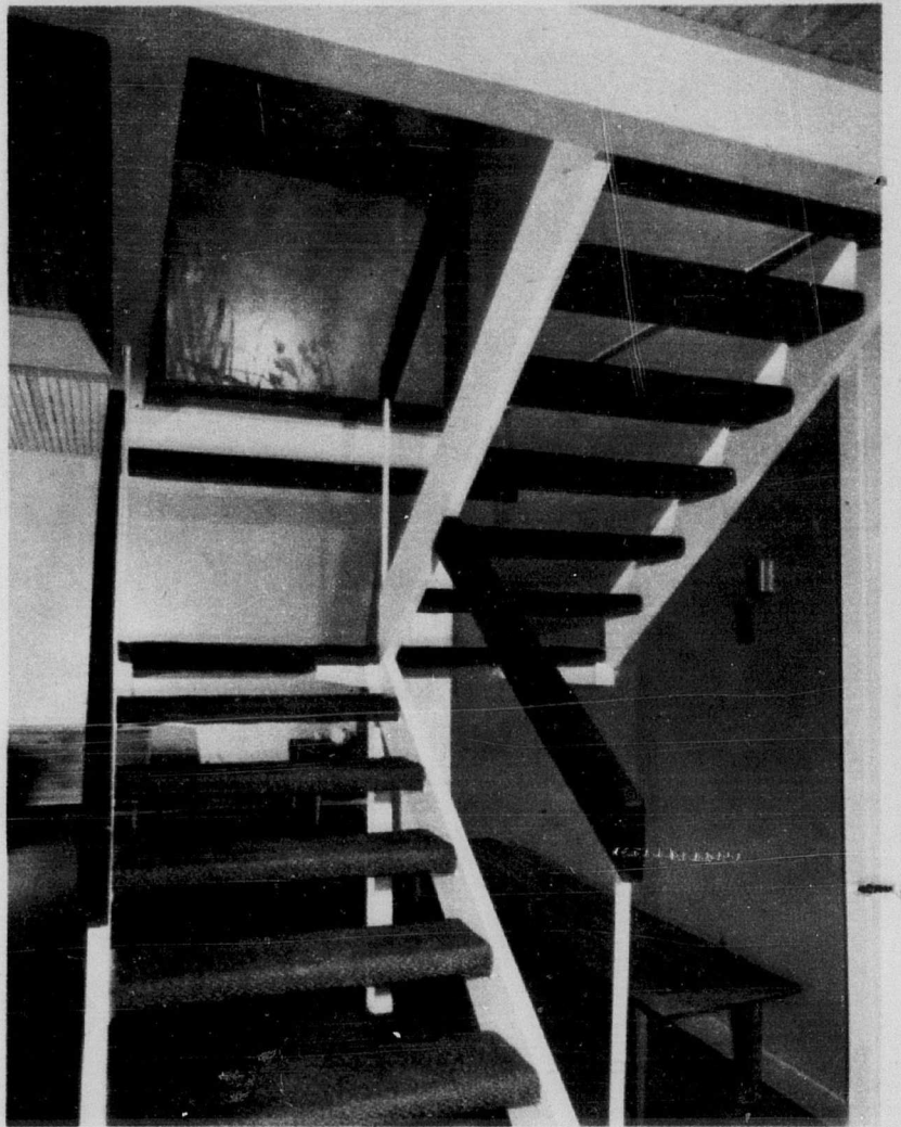
L'escalier intérieur est suspendu au toit par de longs montants. Son profil aérien est encore accentué par un panneau mural lumineux sur le palier.
