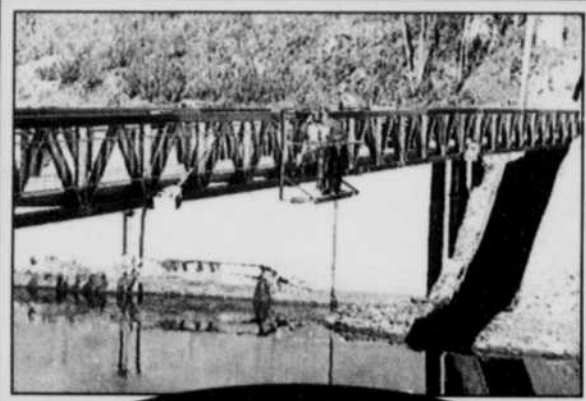
Pont suspendu à la Cité de l'Énergie.
