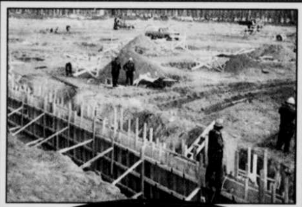
Premières fondations du Centre Fiscal.
