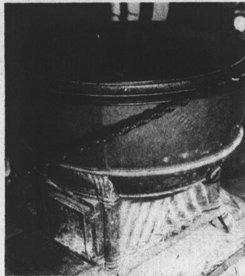
Poêle superposé d'une cuve de quarante gallons, amovible, servant à fabriquer des teintures dans une industrie de confection de couvertures, au XIXe siècle.
