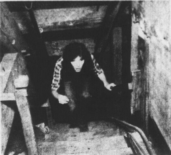
La voie d'accès qui mène à la voûte (entre le toit et le plafond) est pour le moins restreinte. Attention à la tête...
