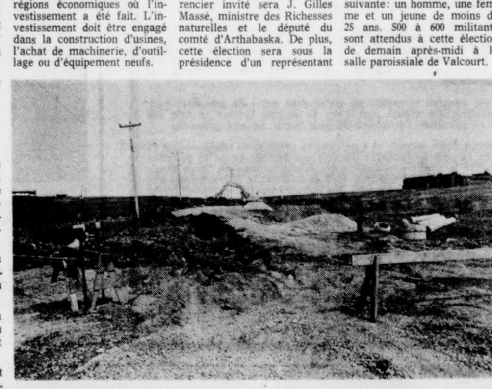
Reprise des travaux Les travaux d'installations de systèmes d'égouts pluvieux et sanitaires sur la rue Laurier à Richmond ont repris avec la venue de la douce température et se poursuivront pour une période indéterminée. Jusqu'ici, la ville de Richmond a emprunté quelque $245,000 pour effectuer ces travaux dans différentes parties de la ville et projette un nouvel emprunt de l'ordre de $70,000 pour compléter l'ouvrage. (Photo La Tribune, Denis Marchand)
