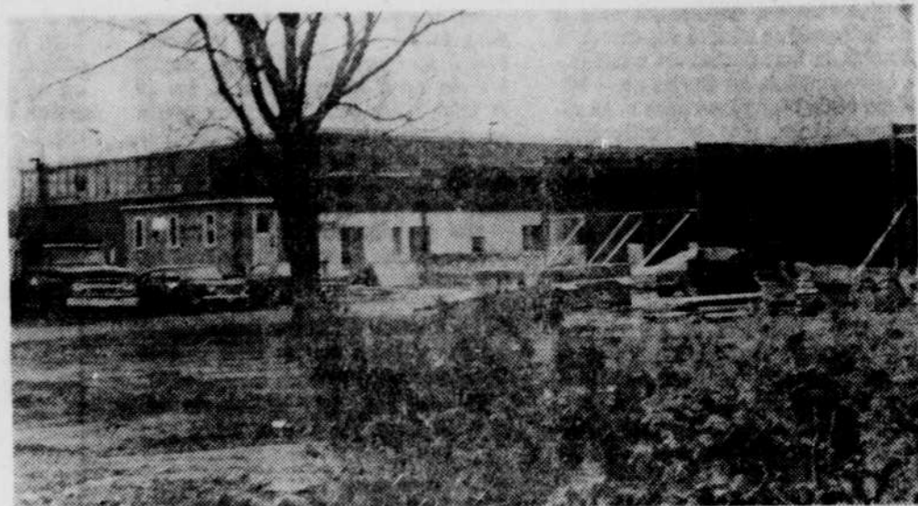
La nouvelle construction de 40,000 pieds carrés de la nouvelle usine de la Eastern Paper Box & Tube, du boulevard Lemire, va bon train, comme on peut le voir par cette photo. Il s'agit en fait d'un agrandissement de l'édifice occupé autrefois par Eastern Industries. Le coût des travaux est estimé à $300,000 et il sera terminé en août. (Photo La Tribune, par Jacques Mathieu)
