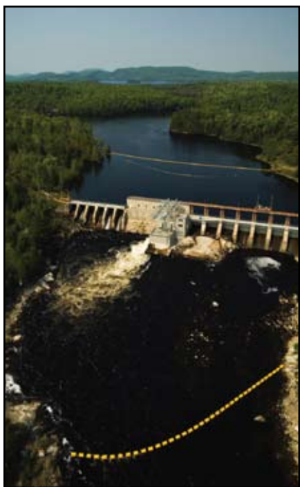
Energie renouvelable Brookfield
