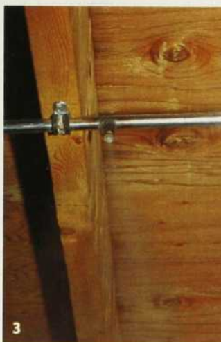
L'eau pulvérisée refroidit l'air et ne mouille pas les animaux ni les équipements si le débit d'air entrant est suffisant.
