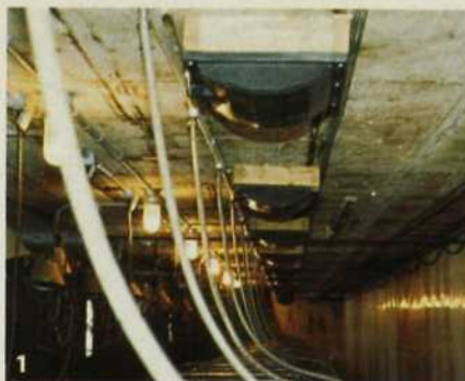
Les entrées d'air modulaires peuvent être installées dans des bâtiments neufs ou existants, ou utilisées en complément d'un système de ventilation déjà en place, comme chez les Santerre.
