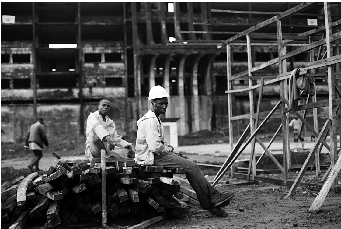
Des hommes s'offrent une pause devant un centre d'isolement en construction à Monrovia, au Liberia. Le pays a reçu une aide de 3,2 millions de dollars de la part de la Chine, mercredi.
