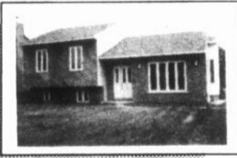
I-678. CONTRACTEUR: prend toute offre raisonnable, maison jamais habitée, plafond cathédrale, salon et salle à manger, sous-sol fini. Robert Bessette
