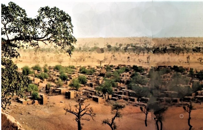
Village de Teni Tomboli au pied de la falaise de Bandiagara. On aperçoit la mosquée environ au centre.
