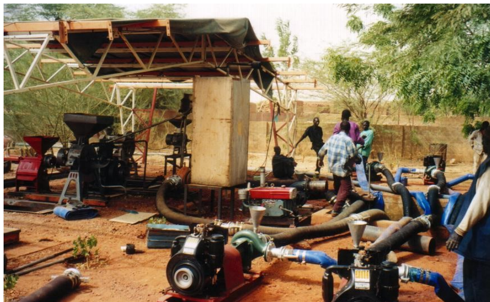
En reprise: l'atelier de la plateforme multifonctionnelle.
