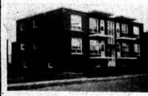
21 Jolicoeur, 8 loyers. Chauffage électrique.
