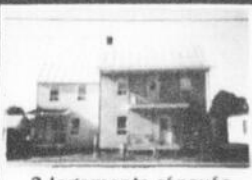
3 logements rénovés 2103 St-Louis
