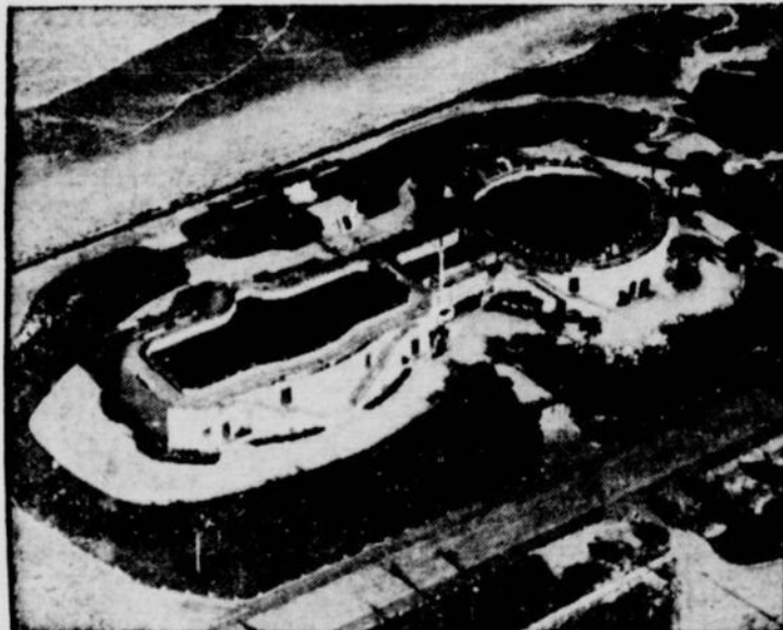
Vue aérienne des studios maritimes.
