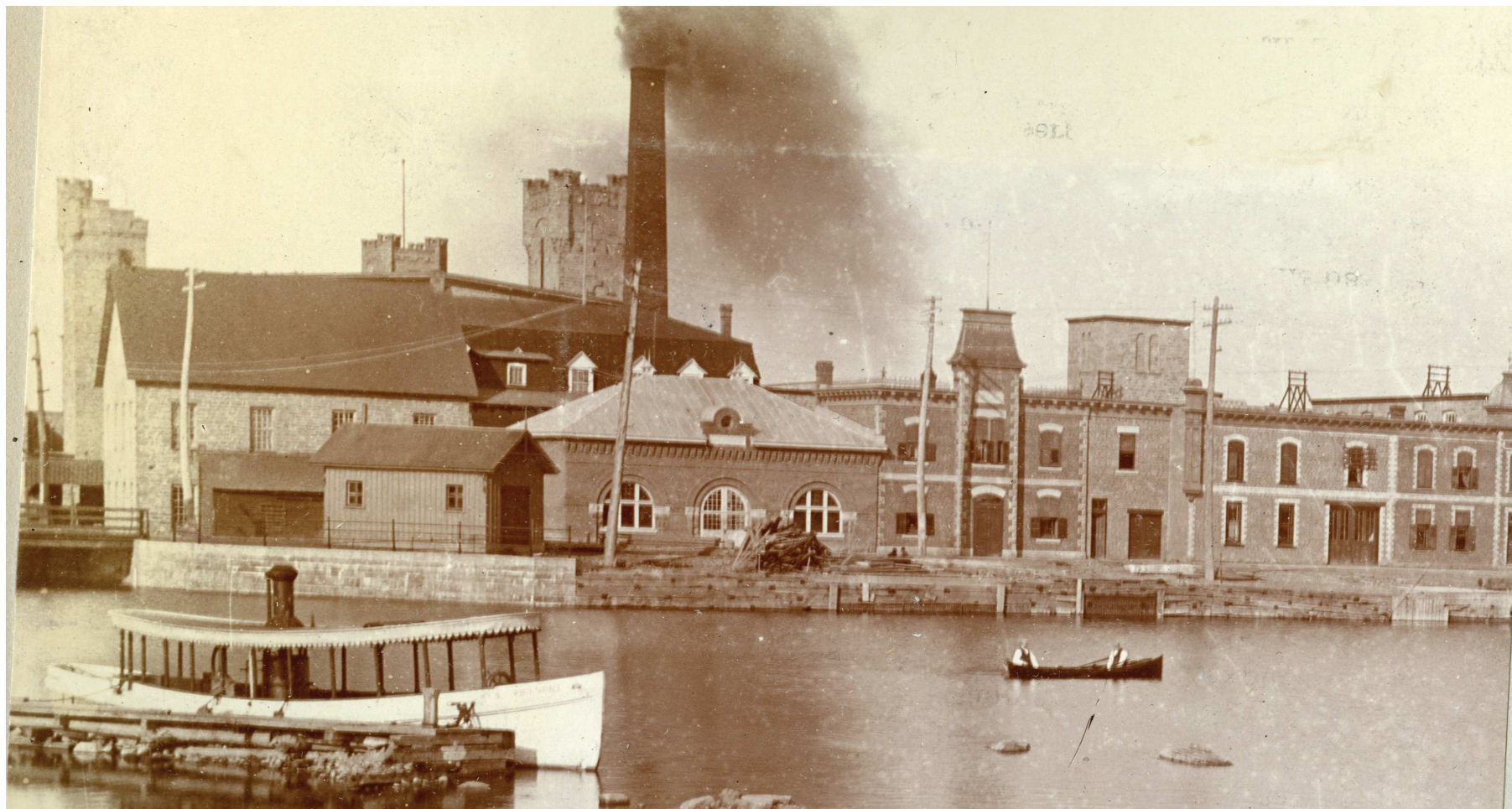
Figure 11 : Bâtiment de l'aqueduc de Salaberry-de-Valleyfield, visible au centre de la photo.
