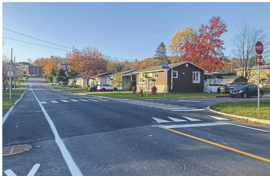
L'intersection de la rue Dubreuil et Lionel-Groleau a connu une modification majeure cette automne avec la construction d'une première intersection surélevée.
