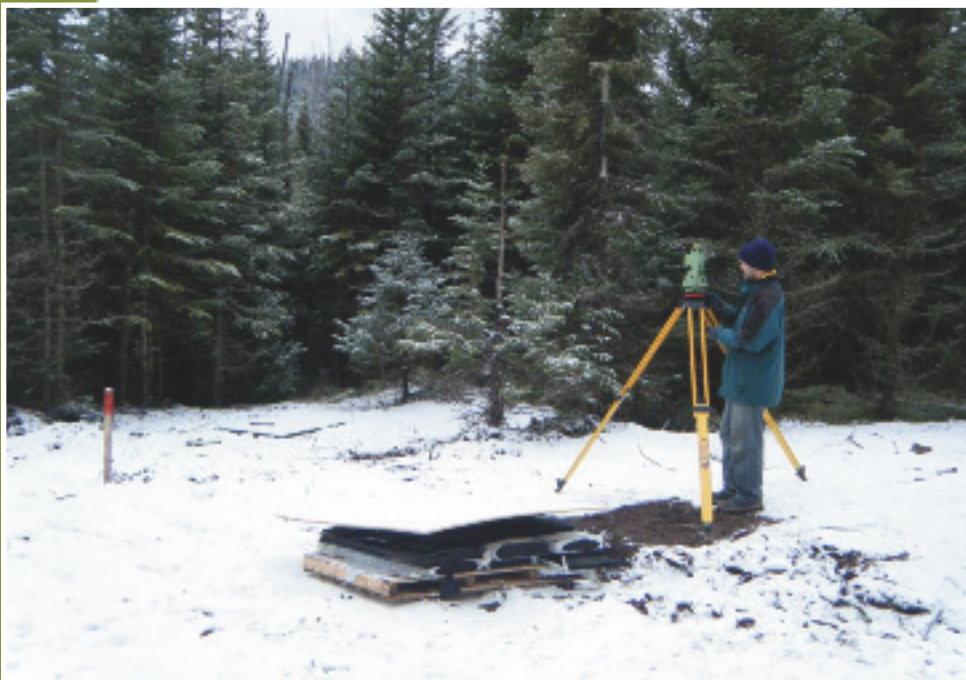
Relevé : l'étude de la topographie du site permet d'identifier tous les éléments pouvant influencer la localisation ou l'implantation du dispositif de traitement des eaux usées.
