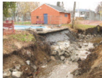
Figure 1. Dommages provoqués par l'érosion d'un cours d'eau à Farnham. Crédit photo : MRC Brome-Missisquoi
