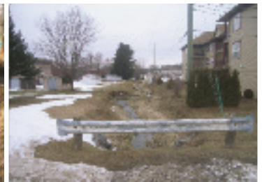
Figure 2. Modification du lit d'un cours d'eau à Bedford menaçant des infrastructures. Crédit photo : MRC Brome-Missisquoi
