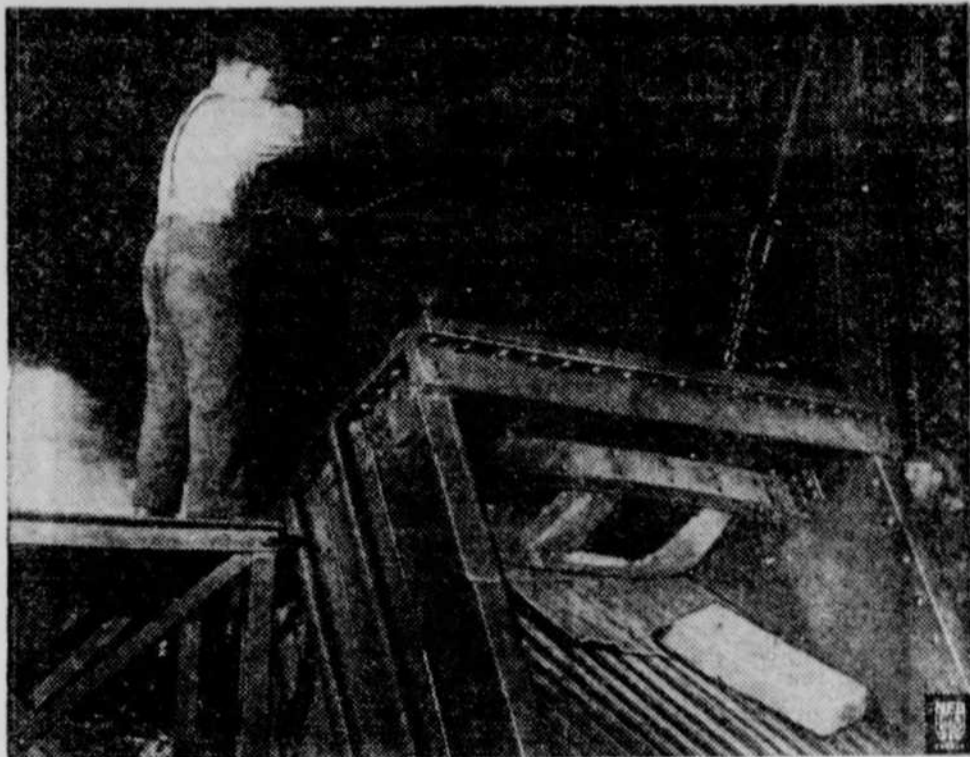
● Cette photographie a été prise dans un des haut-fournaux de la ville minière de FLIN-FLON, au Manitoba. Les riches mines, d'où on extrait divers minerais utiles en temps de paix autant qu'en temps de guerre, ont des puits qui vont jusqu'à une profondeur de 3.500 pieds. — On voit ici un ouvrier surveillant la coulée et le refroidissement d'un bloc de cuivre de 500 livres. De ce bloc on extraira ensuite de l'or, de l'argent, etc.
