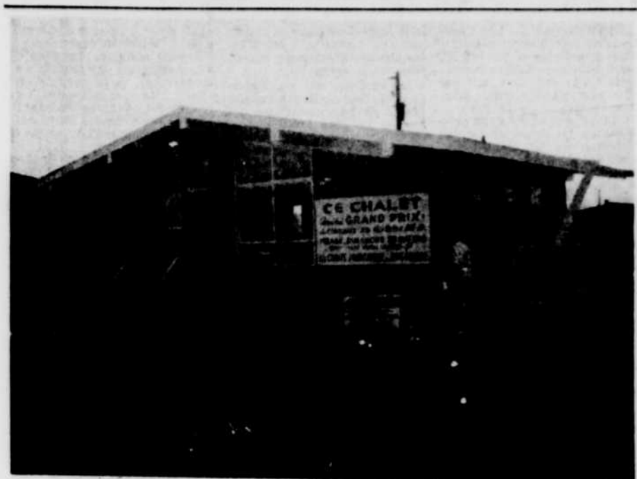
DES OUVRIERS sont actuellement à mettre la dernière touche au magnifique chalet d'une valeur de $4,000, qui sera offert comme grand prix du concours Mille Habitation des Bois-Francis, 1965-66. La Semaine des Maisons Modèles se tiendra du 15 au 23 mai prochain. Le chalet sera ouvert aux visiteurs la semaine prochaine. Il est construit sur la rue Giroux à Victoriaville.
