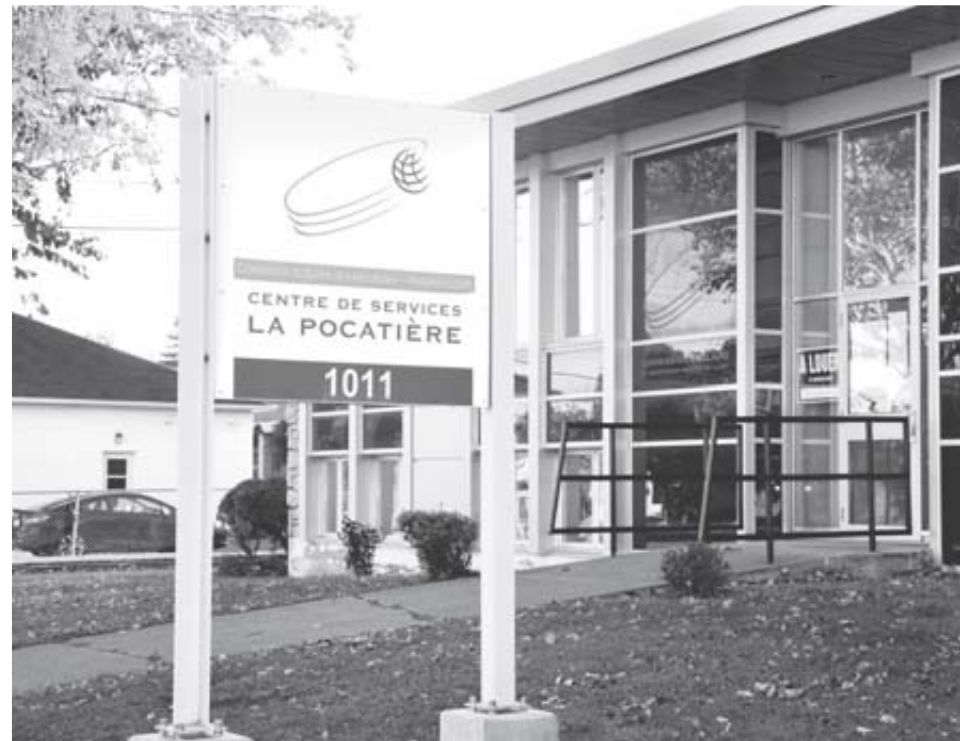
Le centre de service de La Pocatière
