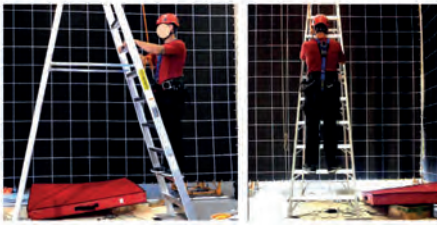
Vérification de la stabilité de l'escabeau – Position de départ.
