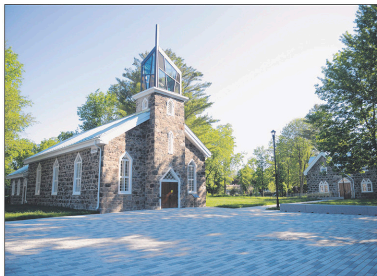
Le Domaine Trinity a été restauré récemment au coût de 5,3 M$ par la Ville de Saint-Jean-sur-Richelieu.
