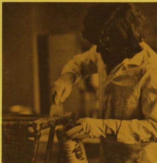
Le grattoir de bois sert à enlever les résidus de vernis et de peinture que l'on dépose ensuite dans le grand récipient.
