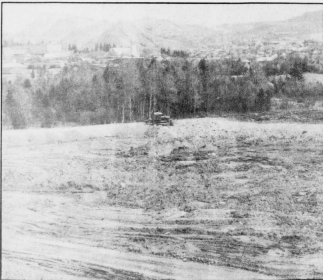
Les autorités de la compagnie minière du Lac d'Amiante du Québec ont déjà commencé les travaux de relocalisation d'une section du
