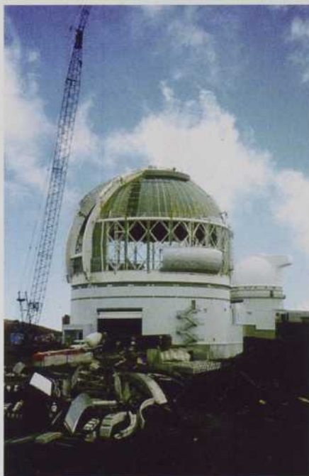
La coupole de Gemini-Nord, en construction au mois de septembre 1997
