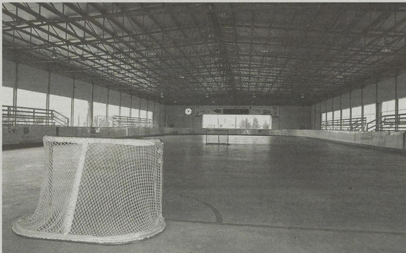
Le Centre Martin-Brodeur sera le premier au Québec à utiliser une nouvelle technologie de réfrigération de la glace.
