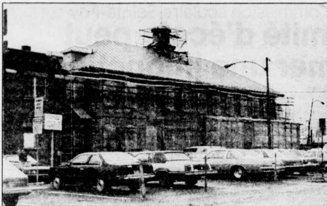
Le terrain de stationnement, situé en arrière de la gare de Lévis, sera entièrement déplacé vers l'ouest, pour contenir autant d'automobiles, soit une cinquantaine.
