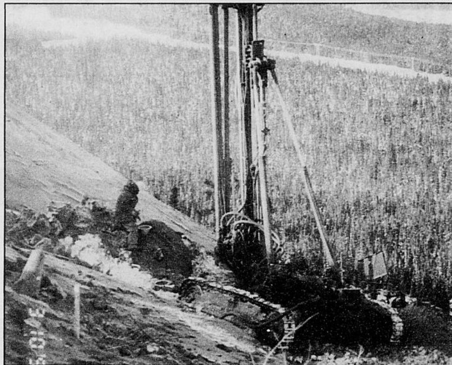
Plus souvent qu'autrement, les foreuses se retrouvent en terrain montagneux et doivent être retenues par un filin d'acier.
