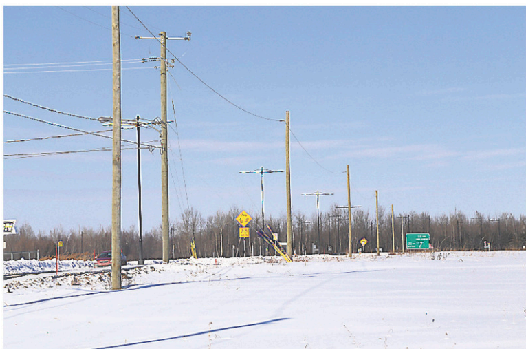
Le MTQ a fait installer une douzaine de poteaux de bois de manière temporaire pour alimenter en électricité les lampadaires du carrefour giratoire de la route 235 à Farnham. Les travaux ont coûté 20 000$. — PHOTO JANICK MAROIS
