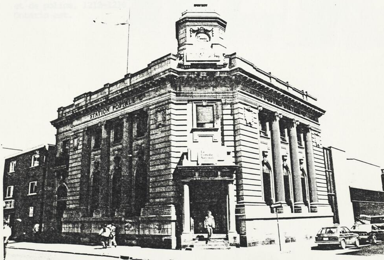
Fig. 88 Bureau de poste, 1450 Ste-Catherine est.
