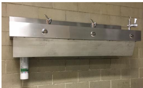
Figure 14 – Jupette métallique de fontaine permettant de cacher la plomberie
