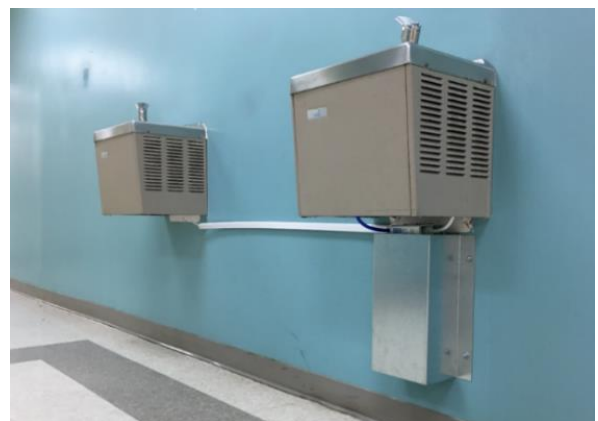
Figure 13 – Plaque de protection attachée horizontalement
